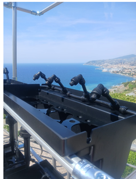
Canalette con sistema di irrigazione integrato e irrigatori regolabili.
